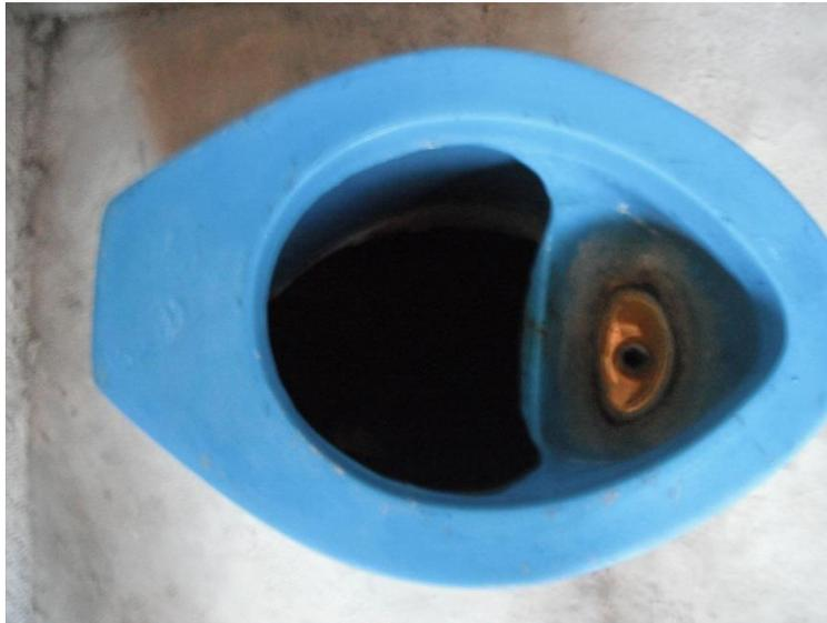
Al usar la taza separadora, el excremento cae en una cámara que se encuentra abajo, donde se almacenará; la orina se desvía hacia un garrafón en el que se almacenará hasta ser llenado. La separación de la orina evita la humedad y los malos olores en este tipo de baño.
