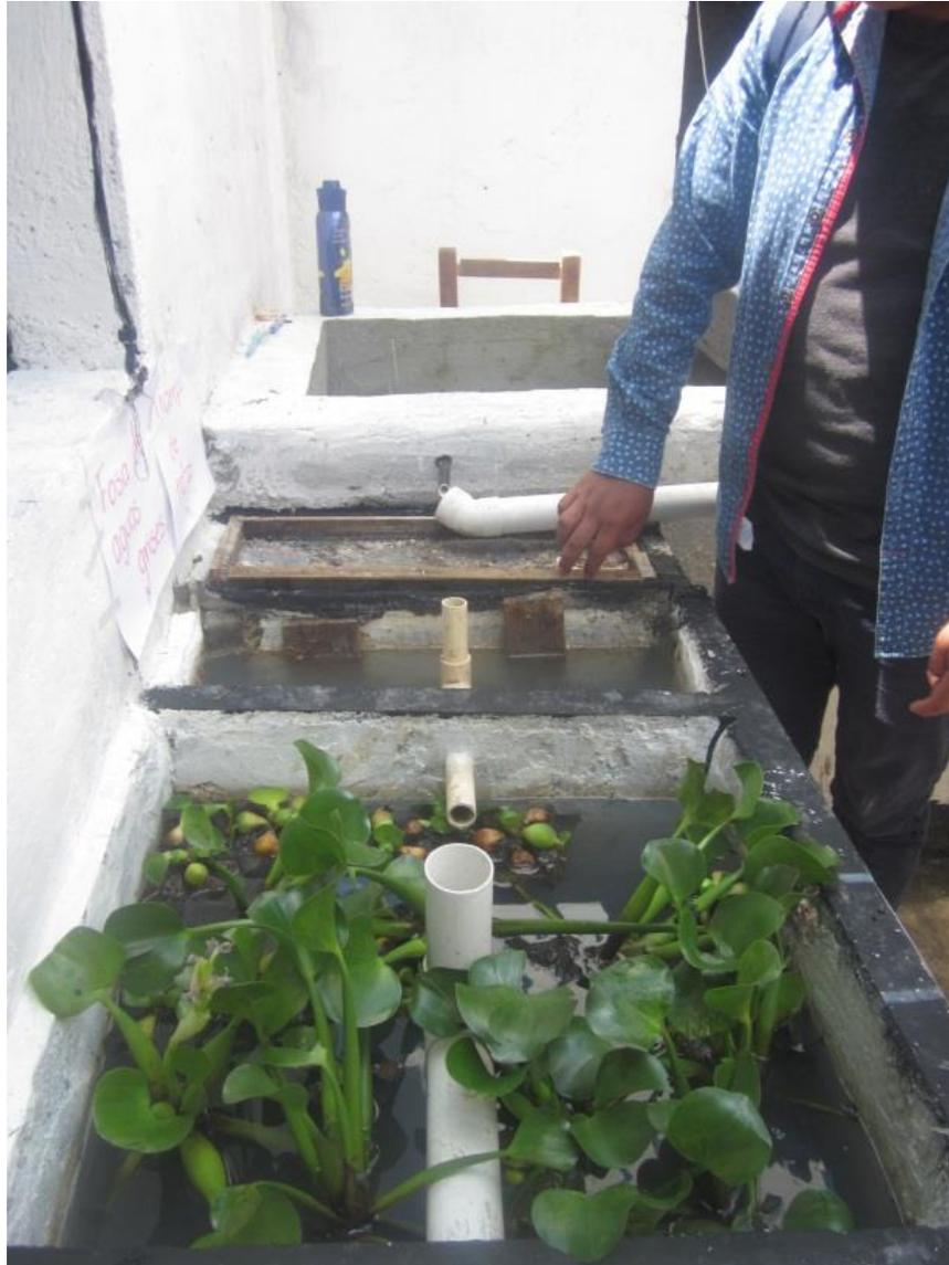
Las aguas negras se depositan en el **biodigestor o fosa de aguas negras**. Ésta consiste en una tina completamente sellada que actúa como el intestino de una persona, por medio de bacterias anaeróbicas (es decir, que no necesitan aire) que degradan la materia orgánica (excrementos) del escusado. El proceso de degradación dura de 30 a 45 días.
